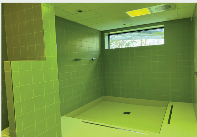
Røyneberg barnehage har eget terapibasseng. Ved å justere fargene på lyset, fargelegges værelset i de sjatteringene en ønsker.
