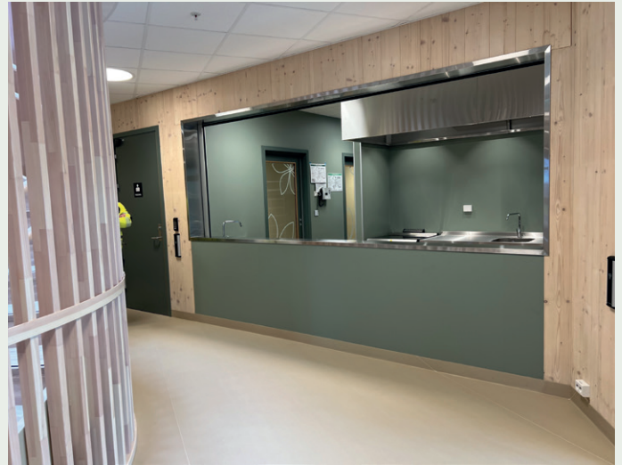
Barnehagens storkjøkken har stor «kaffe-åpning» ut mot inngangsarealet.
